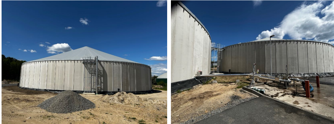
Abbildung 4 Blick auf die bereits errichteten Behälter und die dazugehörigen Nebenanlagen
