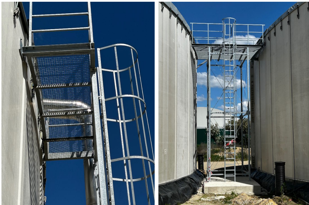
Abbildung 5 Blick auf einige der vorstehenden Teile an den Wirtschaftsdüngerbehälter
