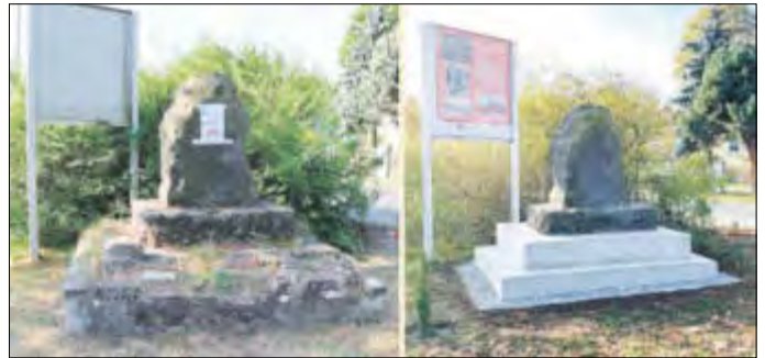
Das Denkmal, vor und nach der Sanierung. Foto: Frank Henschel.
