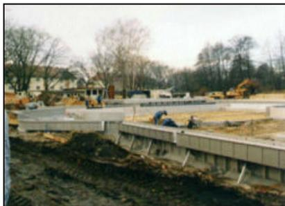
Parallel zur Beckenanlage werden die Rohrleitungen der Wasseraufbereitung montiert und installiert.
